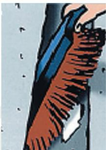
Vorbereitung der Fuge: Schalungsgrate, Betonspritzer, Montageschäume o. ä. entfernen. Fuge mit Drahtbürste säubern. Wenn Dichtmasse nötig, Primer-Voranstrich für elastische Dichtmasse auftragen.
